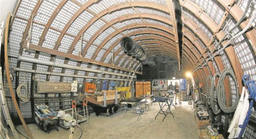
Insgesamt 13 Meter lang und mehrere Meter hoch ist der Lehrstollen auf dem Hof des Stadtmuseums. Der Bergbau-Geschichtskreis hat ihn in etwa drei Jahren ehrenamtlicher Arbeit gebaut und ausgestattet. FOTO: DRAWE
