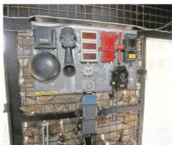
Direkt neben dem Eingang ist die Grubenkommunikation zu sehen: Grubentelefone und diverse Alarminrichtungen, die der Geschichtskreis zusammengetragen hat. FOTO: DRAWE
